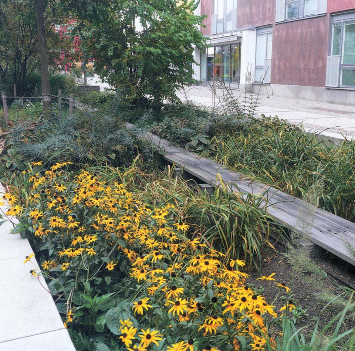
Regnbed med biokul i Hjorthagen, Stockholm. Biokullet kan forbedre de rå forhold som mange planter i urbane miljøer lever under, bl.a. med at forbedre vand- og næringsforsyningen og. Foto: Jonatan Malmberg.
